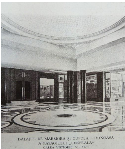
Imobilul Societății Generala din Calea Victoriei nr. 68-70 Building of Generala in Calea Victoriei no. 68-70
